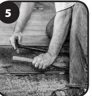
Retire la parte cortada de la cubierta junto con cualquier teja o soldado para despejar la ranura. No corte por las vigas. No corte excesivamente la longitud o el ancho de la ranura.
