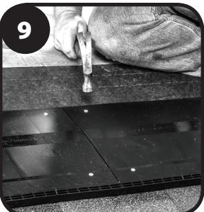
Fije el modelo DA-4 por los 10 orificios para clavos reforzados usando los clavos anillados de 2 1/2" provistos. Deje un espacio de 1/8" entre cada conducto de ventilación para permitir que haya una expansión en climas calurosos.
