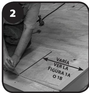
El borde de goteo metálico se debe colocar antes de instalar el modelo DA-4. Usando una cinta de medir y tiza, marque la cubierta para crear una ranura de ventilación de 1" de ancho.
