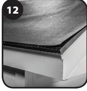
Instale el solado encima del modelo DA-4. Este se debe colocar debajo de la siguiente capa para asegurar que el drenaje del techo vaya encima de la parte superior del conducto de ventilación, modelo DA-4.
