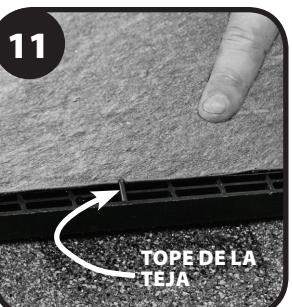
Alinee el borde inferior del soldado con los topes de las tejas en el modelo DA-4 para asegurar que las aberturas de ventilación superior no estén tapadas.
