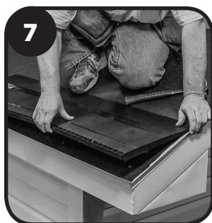
Instale el modelo DA-4 sobre la ranura usando el método de terminación elegido previamente en el paso 1.
