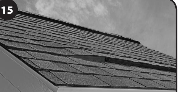
Cuando haya instalado el modelo DA-4, continúe con la instalación normal de las tejas.
