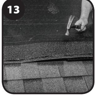
Alinee las tejas iniciales y las de la primera hilera con los topes de las tejas del modelo DA-4 para asegurar que las aberturas de ventilación superior no estén tapadas.
