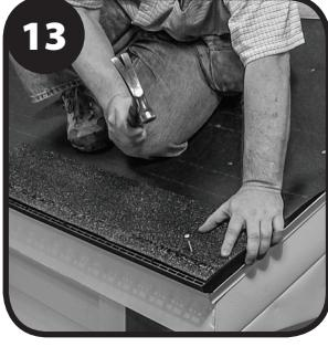
Alinee las tejas iniciales y las de la primera hilera con los tops de las tejas del modelo DA-4 para asegurar que las aberturas de ventilación superior no estén tapadas.
