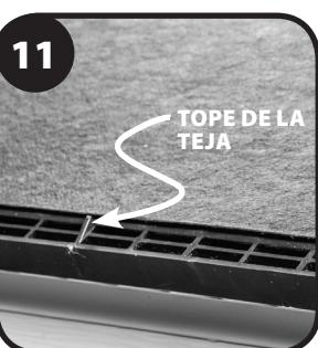
Alinee el borde inferior del solado con los tops de las tejas en el modelo DA-4 para asegurar que las aberturas de ventilación superior no estén tapadas.
