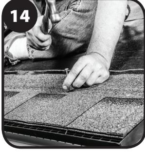
Instale las tejas iniciales y las de la primera hilera encima del solado instalado.
