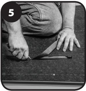
Instale el solado en la cubierta del techo a un mínimo de 18" hacia arriba desde el borde de goteo que cubre el área donde se instalará el modelo DA-4. Retire el solado que cubre la ranura.
