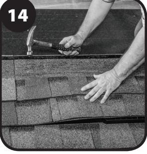
Instale las tejas iniciales y las de la primera hilera encima del soldado instalado. No clave en el área de la ranura de ventilación.
