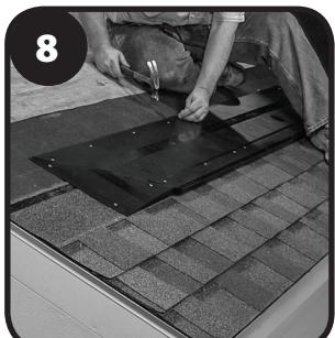
Alinee el borde delantero inferior del conducto de ventilación con el borde expuesto de la teja.
