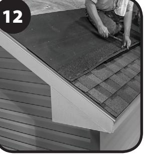
Instale el soldado encima del modelo DA-4. Este se debe colocar debajo de la siguiente capa para asegurar que el drenaje del techo vaya encima de la parte superior del conducto de ventilación, modelo DA-4.
